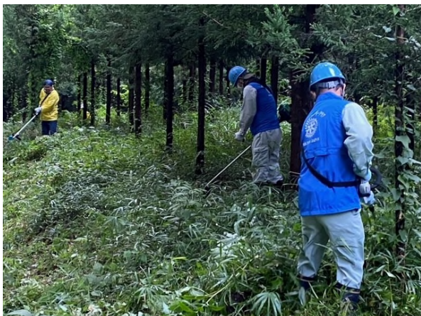
除草作業風景
